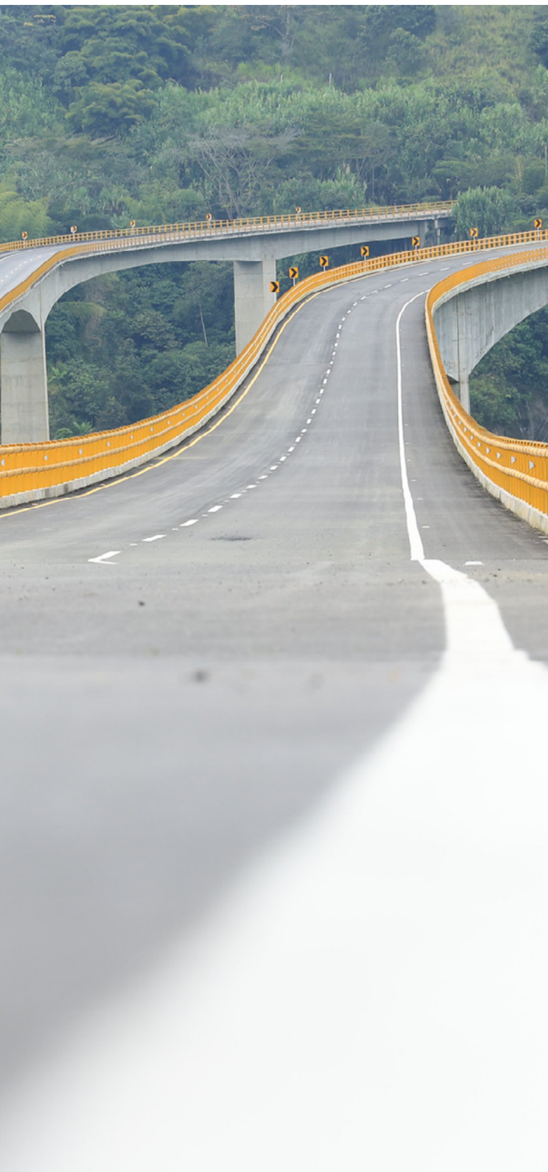
Viaducto Álvaro Mutis Jaramillo, vía Cajamarca
