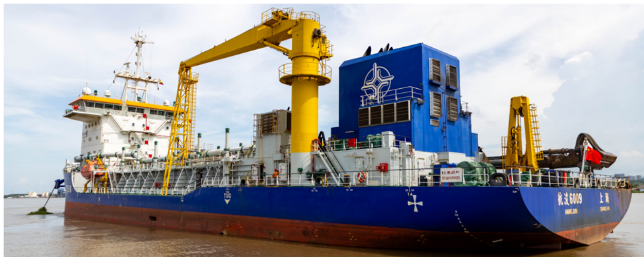
Draga en el Puerto de Barranquilla, operación permanente de mantenimiento esencial para remover la sedimentación del río Magdalena
