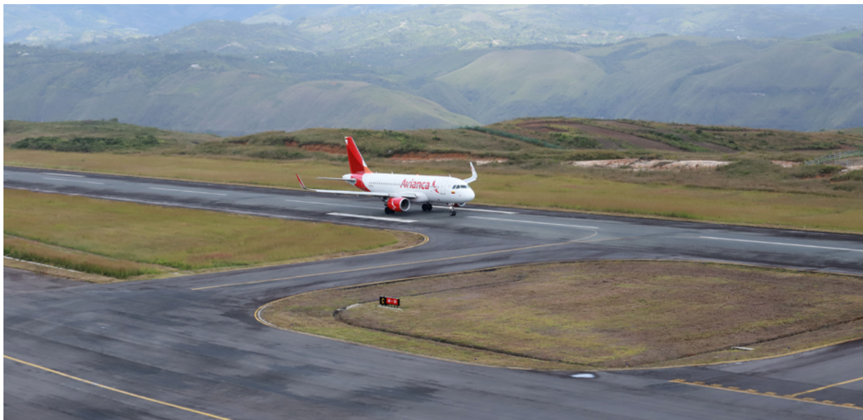
Obras de mejora aeropuerto Antonio Nariño de Pasto
