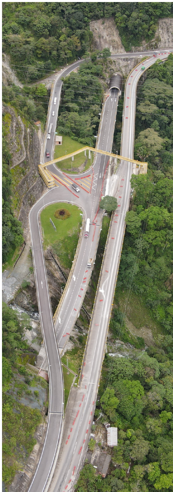
Túnel chirajara-fundadores via bogotá - Villavicencio
