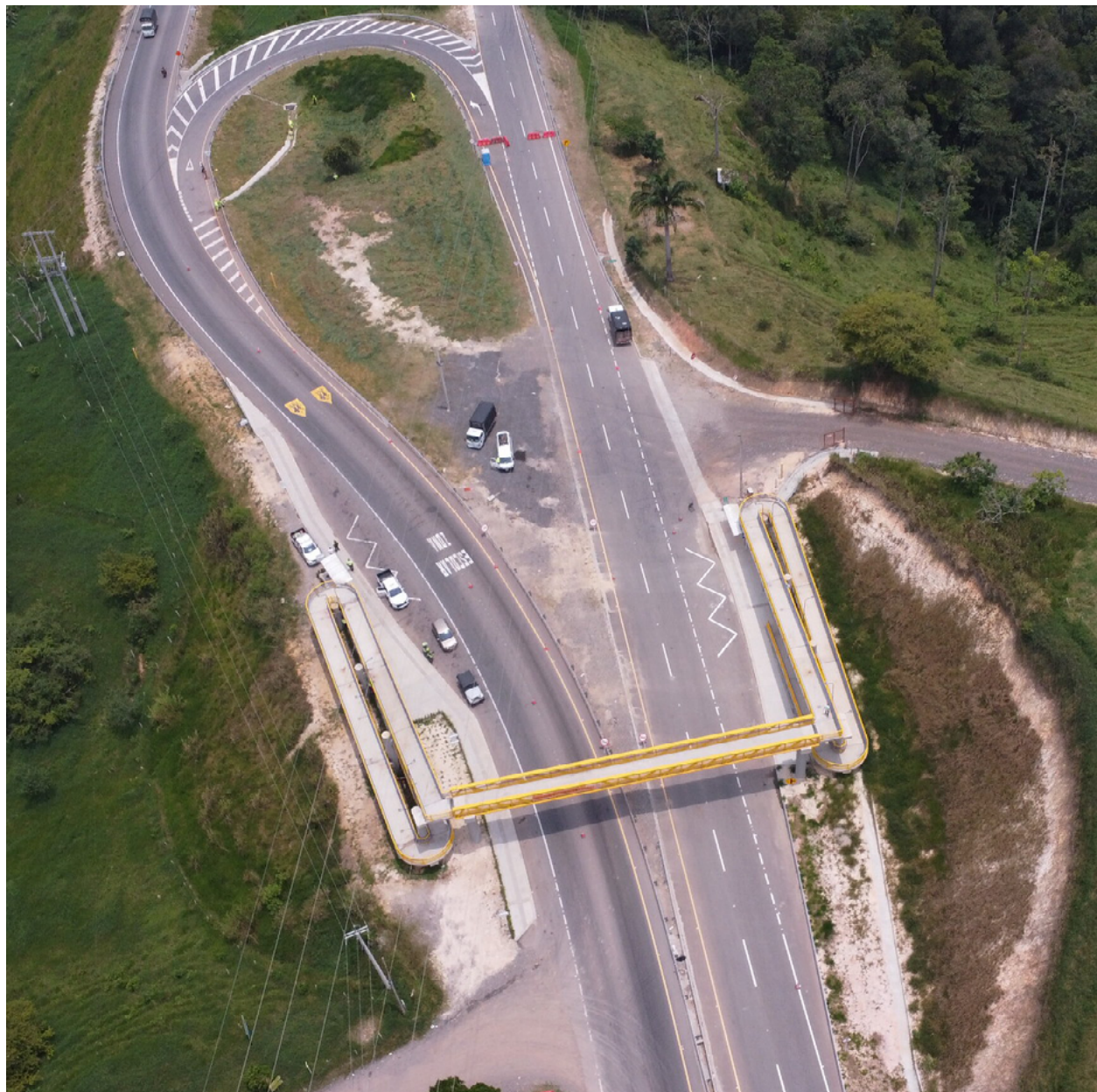
Segunda calzada via Bucaramanga - Barrancabermeja- Yondó
