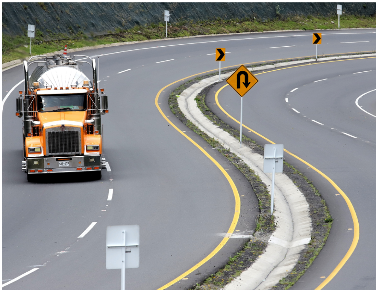
Doble calzada entre los corregimientos de Pilcuán y Pedregal y el municipio de Tangua
