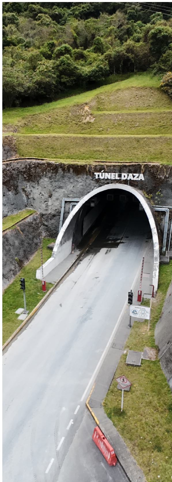
Túnel Daza, via Pasto – Chachagüi
