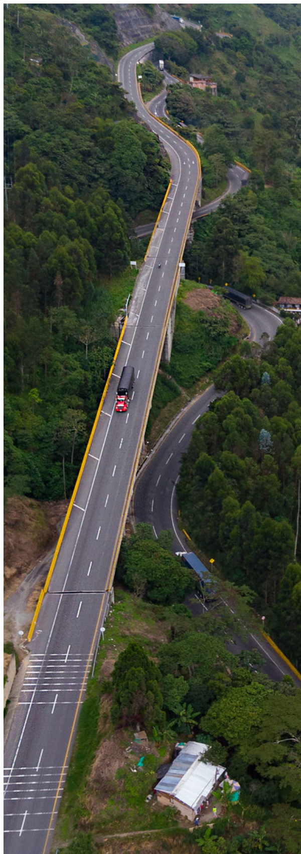
Vía Calarcá - Cajamarca. Cruce de la Cordillera
